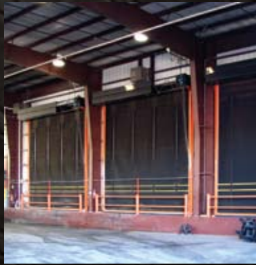
Traitement des eaux usées
